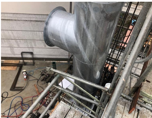
下部煙突(点検口枠+横引煙導フランジ付き)設置
